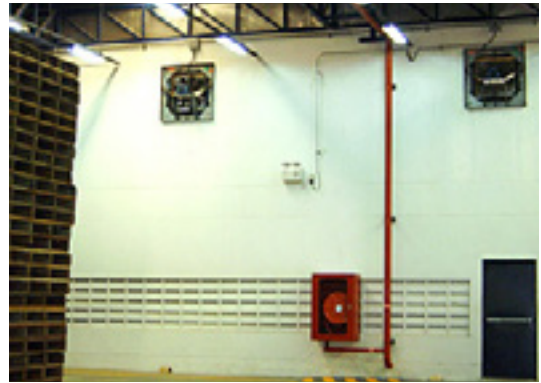
Figura 8: Extractores en un almacén para mantener la humedad relativa
